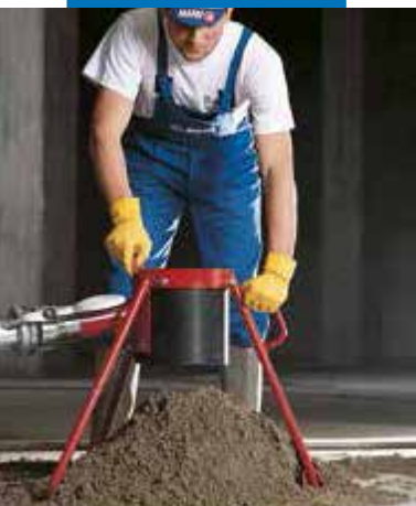
Разбъркване на сместа с Торсет
