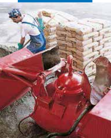
Смесване на Торсет с автоматична помпа
