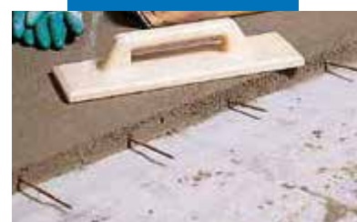
Механично нанасяне на замазка с Торсет
