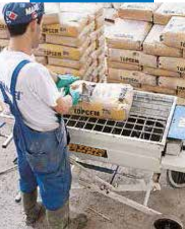
Смесване на Торсет в мини съд за разбъркване на сместа
