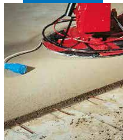
Механично нанасяне на замазка с Торсет
